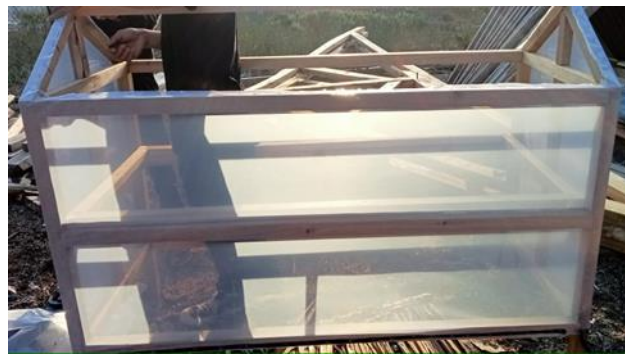
Gambar 3. Pemasangan Plastik UV
