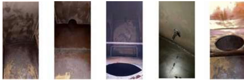
Gambar 9. Kondisi After Kuras Tangki
