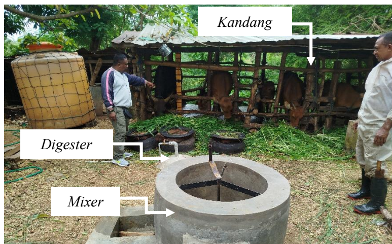
Gambar 2. Kondisi Bangunan Digester Bio Gas di Kelurahan Maulafa
