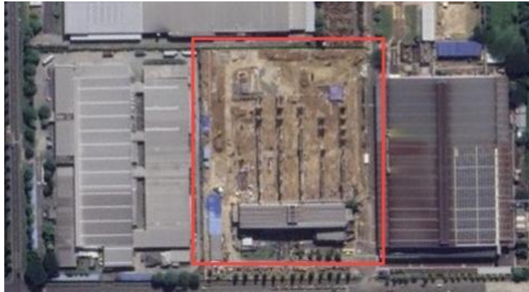
Gambar 1. Lokasi Pembangunan PT. Komatsu New Assembly Cibitung Plant
