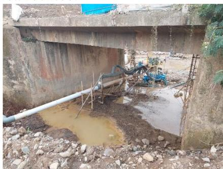
**Gambar 5 Dewatering pada Area Capping**
