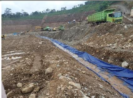
**Gambar 4 Contoh Pengalakan dengan Pembuatan Saluran Drainase Sementara Dewatering**
