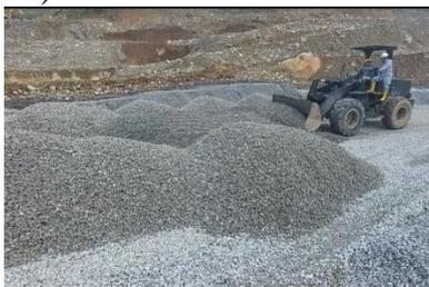
**Gambar 7 Contoh Stok Material Timbunan Horizontal Drain di Area Pekerjaan
