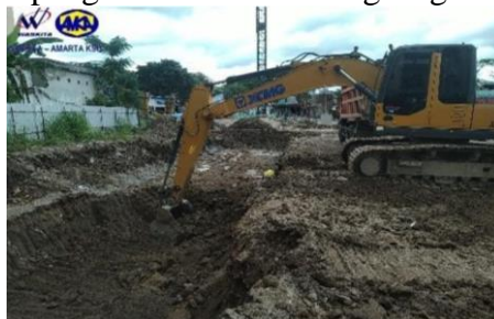
Gambar 2 Proses Penggalian Tanah dengan Ekscavator
