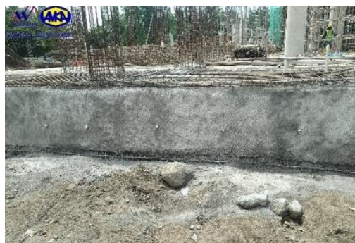
Gambar 11 Hasil Akhir Pekerjaan Shotcrete
