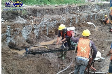
Gambar 3 Proses Pengeboran dengan Rotary Hydraulic Drilling Machine
