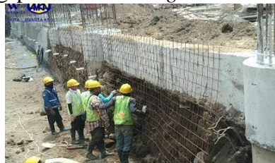
Gambar 7 Pemasangan Wire mesh M6-150 untuk Pekerjaan Shotcrete
