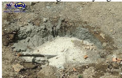
Gambar 6 Hasil Pekerjaan Soil Nailing
