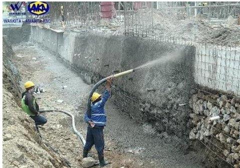
Gambar 9 Proses Pekerjaan Shotcrete
