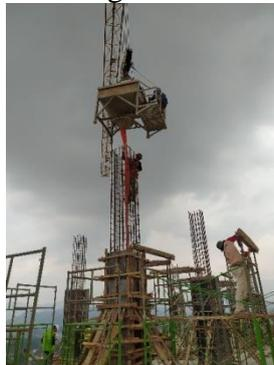
**Gambar 7 Proses Pengecoran Kolom**
