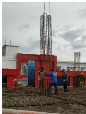
Gambar 5 Proses Pemasangan Tulangan Kolom
