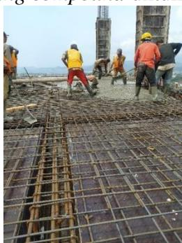
**Gambar 13 Proses Pengecoran Balok dan Plat Lantai**
