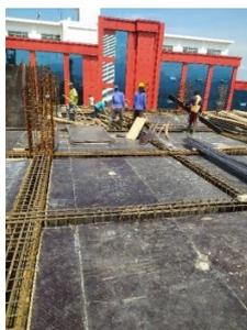
**Gambar 11 Proses Pemasangan Bekisting Plat Lantai**
