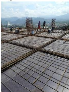
**Gambar 12 Proses Pemasangan Tulangan Plat Lantai**
