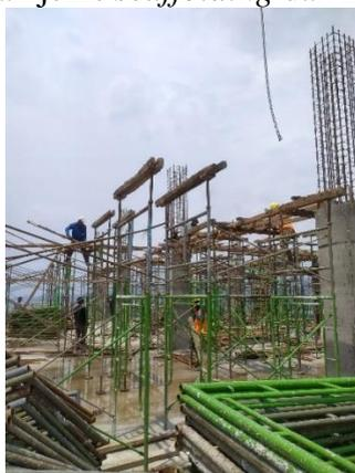
Gambar 8 Proses Pemasangan Perancah untuk Balok dan Plat Lantai
