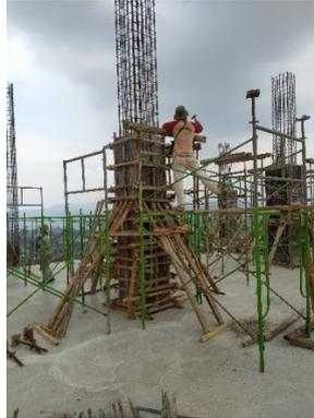
**Gambar 6 Proses Pekerjaan Bekisting Kolom**
