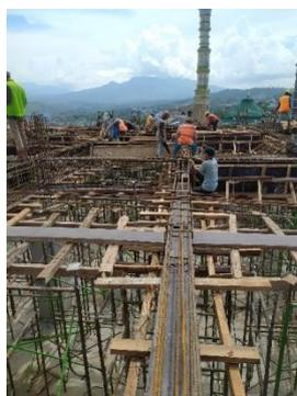
Gambar 9 Proses Pemasangan Tulangan Balok
